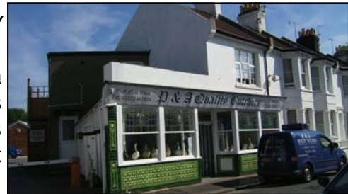
Fig. 31: Nos. 7-9 New Road
